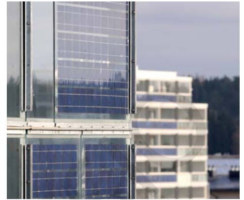
Kuva 2. Aurinkosähköpaneeleja integroituna rakennusten julkisivuun korvaamaan tavanomaisen parvekekaiteen. Kuva Pekka Hänninen
