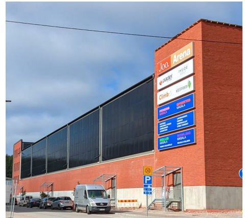
Kuva 26. Paneelisto asennettuna julkisivumateriaalin päälle. Kuva Solarvoima.
