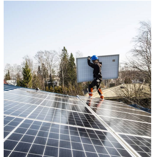
Kuva 20. Kattoasennus käynnissä. Kuva Solarvoima.
