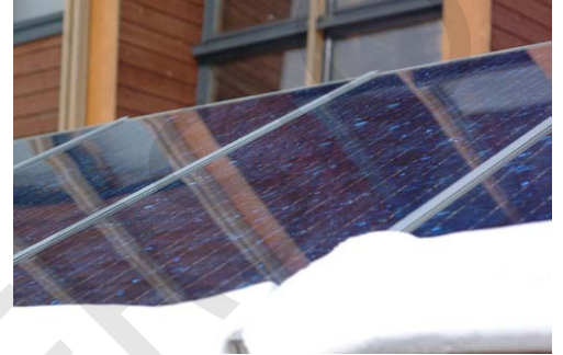
Kuva 30. Aurinkopaneelin tuotto heikkenee oleellisesti sydäntalvella, eikä sitä yleensä kannata puhdistaa lumesta. Kevätaurinko sulattaa lumen tummalta pinnalta. Kuva Pekka Hänninen.
