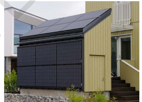
Kuva 3. Kun talon katon lappeet ovat väärään ilmansuuntaan, aurinkopaneelit on sijoitettu osaksi piharakennuksen julkisivua. Lantti-talo, Vuores, Tampere. (Aalto yliopisto 2012). Kuva Pekka Hänninen.
