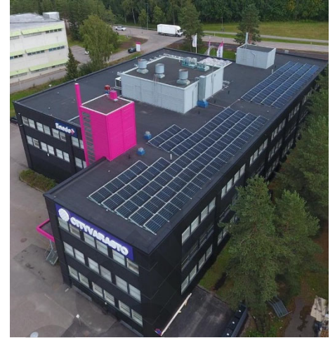
Kuva 18. Liike- ja toimistokiinteistöissä aurinkosähkön tuotanto ja kulutus osuvat paremmin samoille päivätunneille. Kuva Solarvoima.
