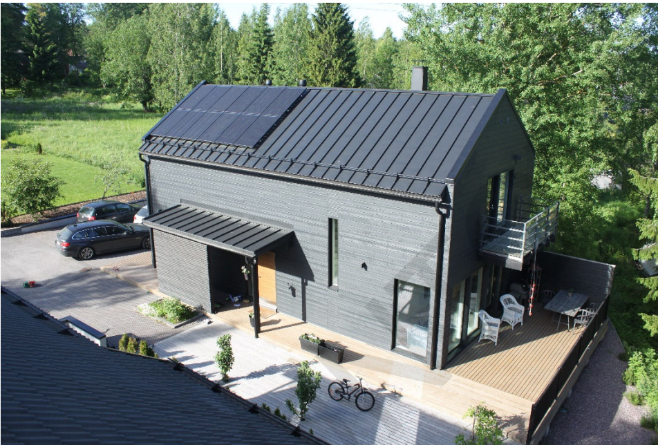
Kuva 1. Aurinkopaneelisto (full black paneeleita) osana vesikattoa istuu luontevaksi osaksi talon ulkoarkkitehtuuria. Kuva: Lauri Hietala /Solarvoima
