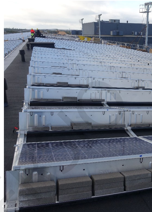
Kuva 16. Paneelistöasennusta loivalla noin 25 m korkean teollisuushallin kattoja meren rannassa. Paneelit ovat asennettu loivaan kulmaan vaakasuuntaisesti kohti etelää. Poikkeuksellinen tuulikuorma on huomioitu paitsi loivalla asennuksella ja tuulensuojapellein, niin erityisesti peltien päälle olosuhteiden mukaan mitoitettuun betonipainoin. Kentän reunarivillä (kuvassa etualalla) on 2,5 kertainen painomäärä verrattuna seuraavaan riviin ja yli 15 kertainen painomäärä verrattuna kentän keskialueisiin. Kuva Ulvilan sähköasennus.
