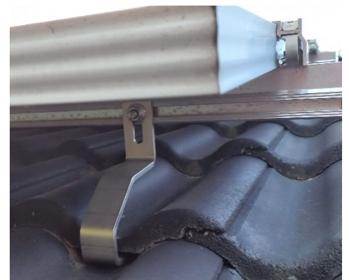
Kuva 22. Tiilikatekiinnitys S-mallisella kattokannattimella. Kannattimen paikka säädetään niin, ettei se lepää alemman kattotiilen päällä edes kuormituksen alaisena. Kuten kuvassa, yleensä kiinnikkeen päälle tulevaa tiiltä joudutaan hiomaan alareunastaan ns. vesilukon kohdalta sen varmistamiseksi, ettei tiili lepää kiinnikkeen päällä. Kuva Teemu Heikkinen.
