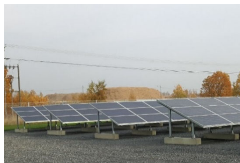
Kuva 27. Painoperustainen maa-asennus kiinteällä kulmalla. Kuva Teemu Heikkinen
