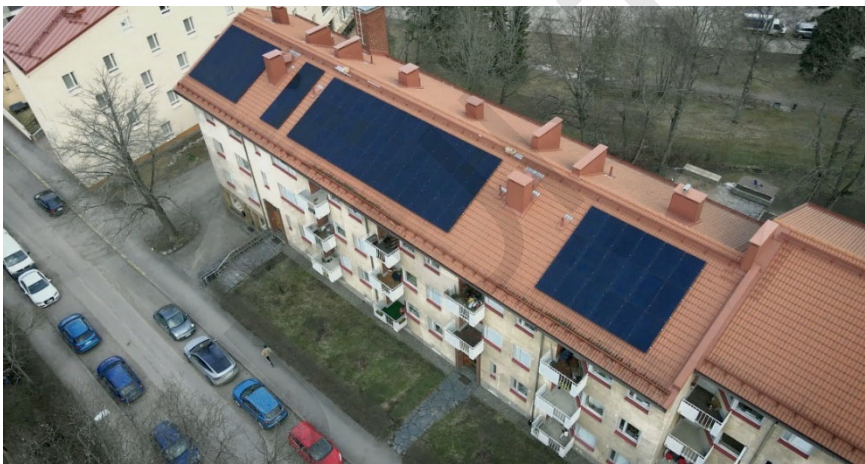
Kuva 11. Esimerkkikuva aurinkopaneelien sijoittamisesta vanhan rakennuksen katolle. Kiinteistönomistajan on huomioitava myös järjestelmän vaikutukset katon huollettavuuteen ja esim. lumen putoamiseen ja pudottamiseen. Kuva Solarvoima.
