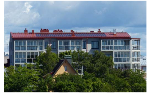
Kuva 25. Asennettu ohutkalvopaneeli asuinkerrostalon saumapeltikatolla Hangossa. Järjestelmään kuuluu harjalista, jonka alle jäävät paneelien kytkentärsiat ja DC-kaapelointi. Kuva Jaakko Virtanen, Virte Solar
