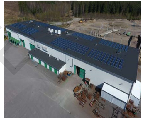
Kuva 12. 90 kW:n aurinkovoimala teollisuusrakennuksen katolla. Katon rakenteet sekä tarve mahdollisille lumitöille huomioidaan suunnittelussa ja asennuksessa. Kuva Janne Käpylehto
