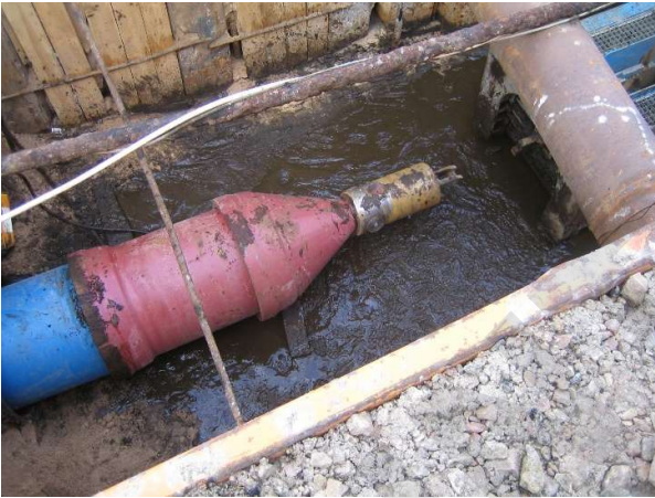
Kuva 7b. Paineellisen putken pitkäsujutus.
