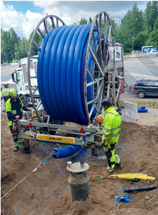
Kuva 3. Muotoputkisujutus.
