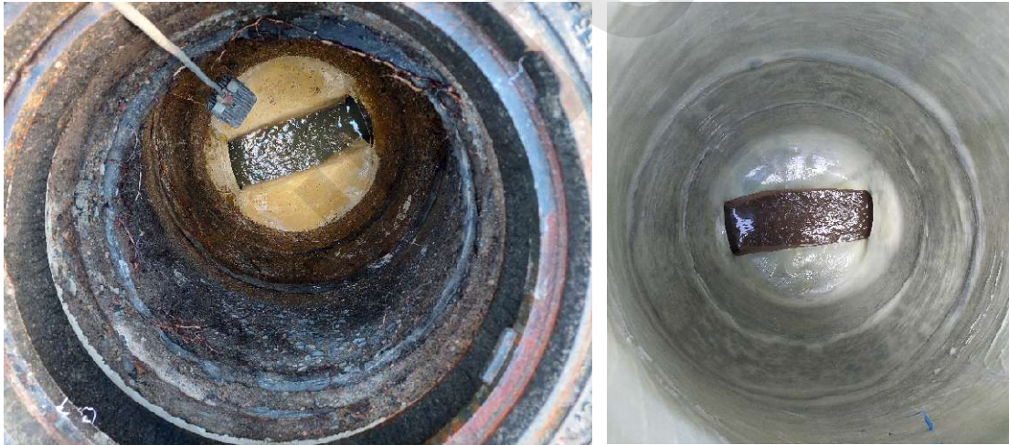
Kuva 20. Kaivo ennen ja jälkeen sukituksen.
