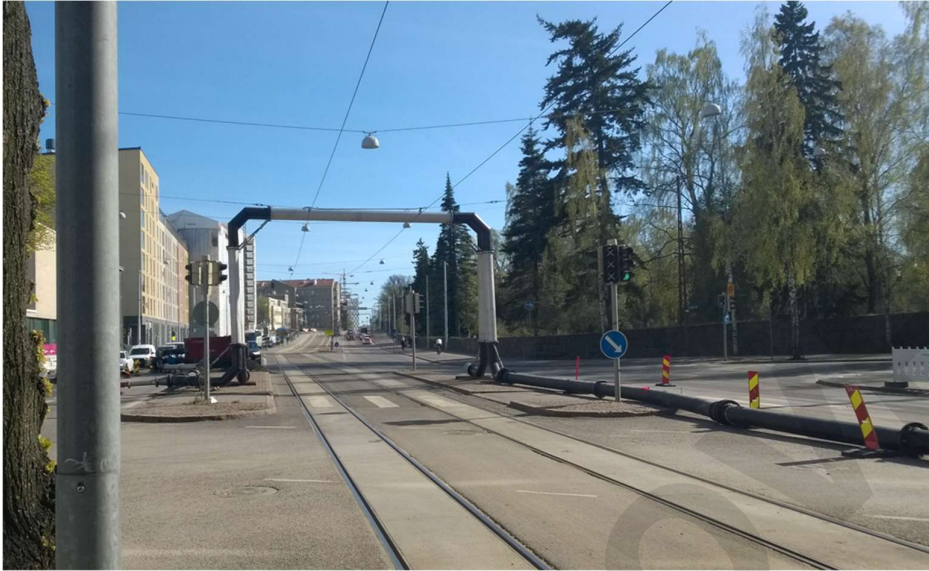
Kuva 1. Viemärivereden ohipumppaus.
