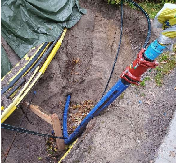
Kuva 7a. Paineellisen putken pitkäsujutus.
