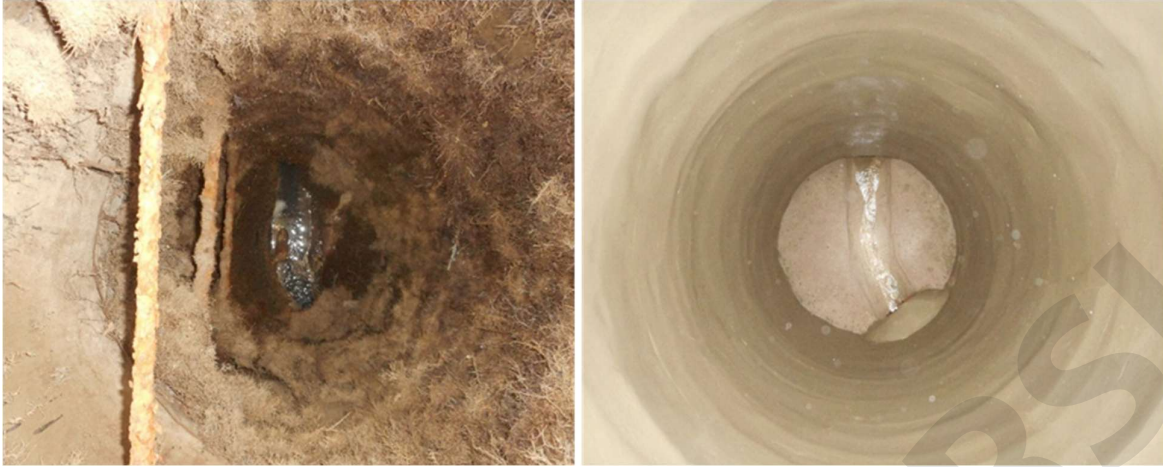
Kuva 16. Kaivo ennen ja jälkeen sementtilaastivuorauksen.
