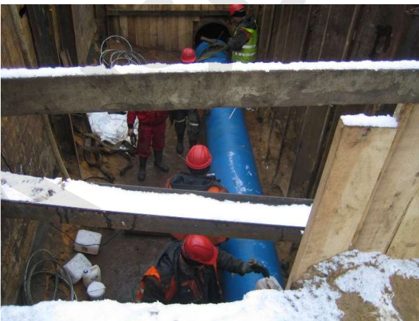
Kuva 7c. Paineellisen putken pitkäsujutus.
