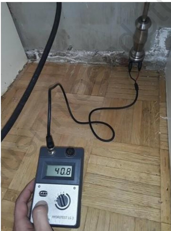
Kuva 13. Piikkimittaus sauvaparketin saumasta seinän vierestä.
