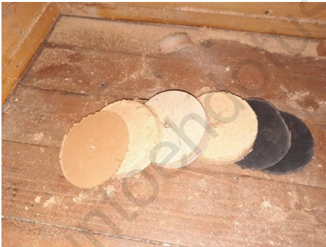
Kuva 8. Rankarunkoisen rakenteen tarkastus rasiaporalla. Rakennekerrokset saadaan tarkasti selville ja dokumentoitua.
