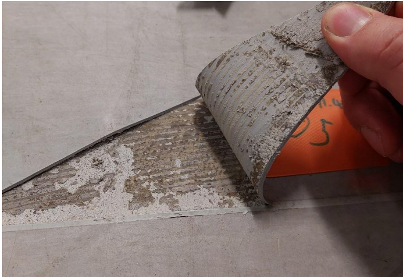
Kuva 15. Viiltomittauksessa mittaustuloksen lisäksi tuloksen tulkintaa varten on tärkeää arvioida aistinvaraisesti muovimaton alla oleva liima ja tasoite. Maton alla voi olla väri-, tai koostumuseroja, sekä poikkeavaa hajua. Kuvassa muovimaton alla on silminnähtävää mikrobikasvustoa, joka viittaa välitöntä kastumista pidempiaikaiseen kosteusrasitukseen. Myös tällaisten aistinvaraisten havaintojen vaihtelua vahinko- ja referenssialueen välillä tulee havainnoida.
