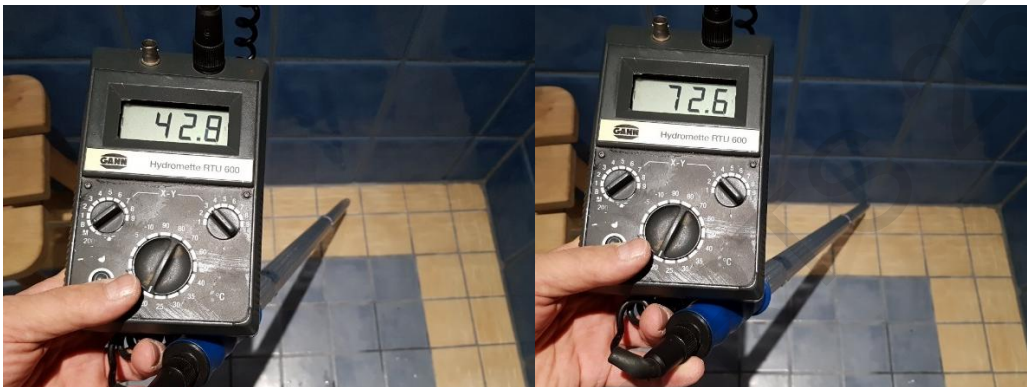
Kuva 10. Kuvaparissa pintakosteudenilmaisimella mitattu sama keraaminen laatta noin 5 cm etäisyydeltä seinästä sekä seinä-lattialiittymän kulmauksesta. Näyttämä kulmauksesta on virheellinen, sillä mittapään kuula koskettaa kahta pintaa samanaikaisesti.
