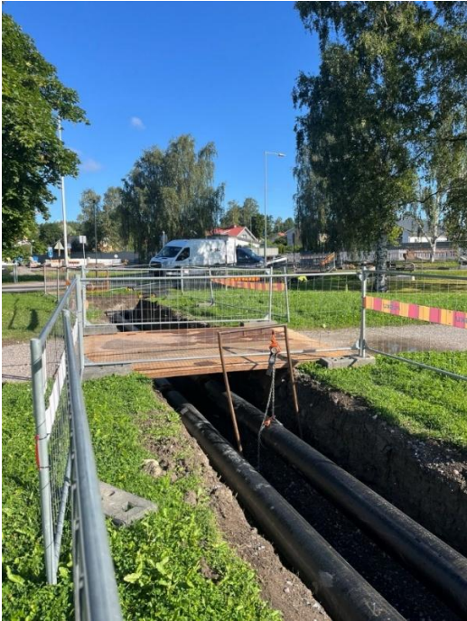
Kuva 1. Kaukolämpöputkiston asentamista.
