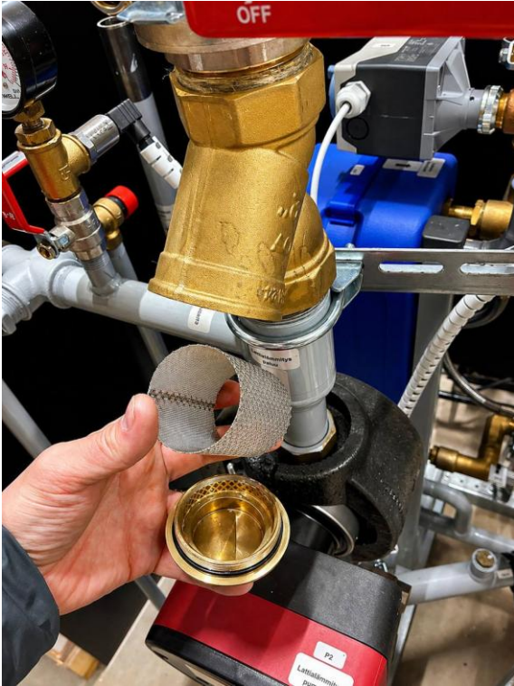
Kuva 7. Lianerotin kansi irrotettuna ja puhdistettu sihti.
