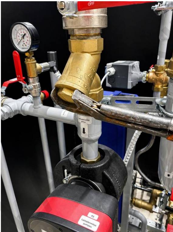
Kuva 6. Mutasihdin puhdistus. Avaa lianerotin, tyhjennä ja pese lianerottimen sisällä oleva suodatinsihti.
