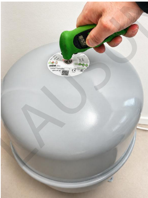
Kuva 9. Mittaa paisunta-astian esipaine, lisää tarvittaessa tyypeä. Oikea esipaine ilmoitetaan kytkentäkaaviossa. Mikäli esipainetta tarkastaessa paisunta-astian venttiilistä tulee vettä, on paisunta-astian kalvo rikkiöontunut. Tällöin paisunta-astia tulee uusia tai korjata.
