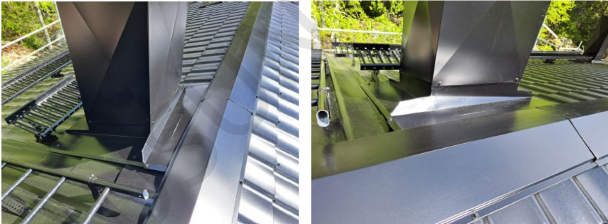
Kuva 42. Esimerkki hormin yläpuolen vastakallistuksesta.
