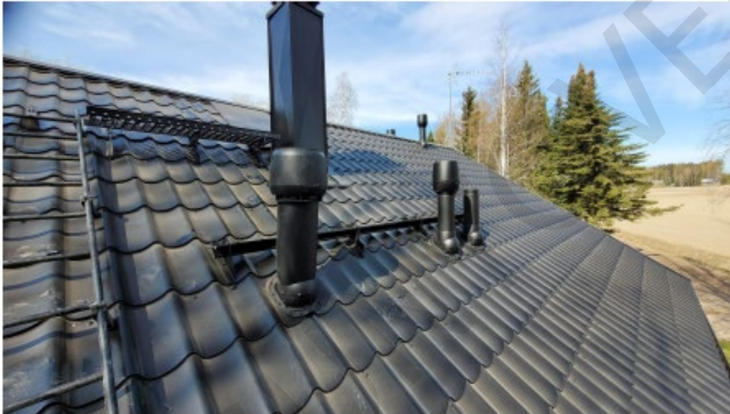
Kuva 11. Vesikaton läpivientiosia. Jos lumen ja jään valuminen muodostaa läpivienneille vaurioitumisriskin, ne suojataan lumiesteillä. Huollettaville kohteille järjestetään katolle kulkuyhteys.
