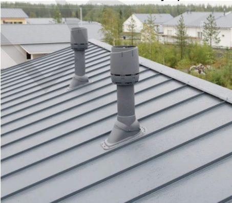
Kuva 43. Esimerkkejä alipainetuulettimen läpivienneistä.
