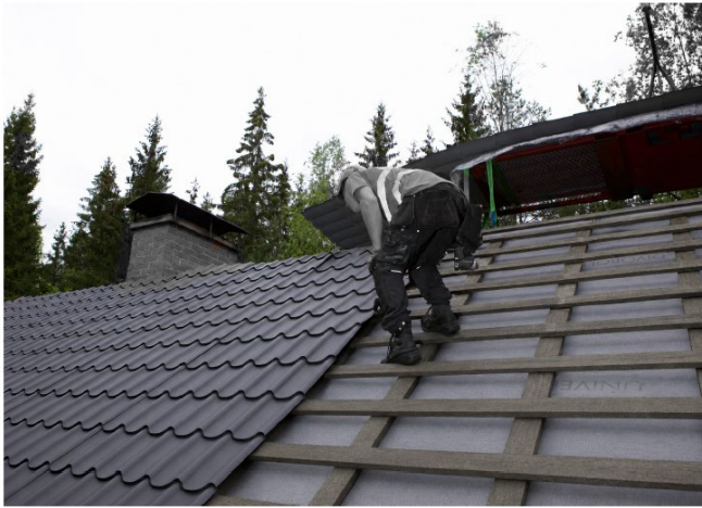
Kuva 14. Muotolevykateen asentamista.
